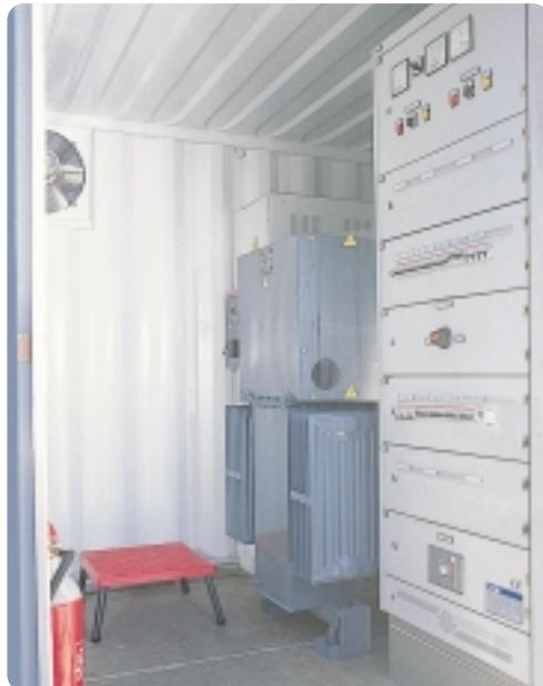
Vano con quadri di media e bassa tensione e trasformatore
